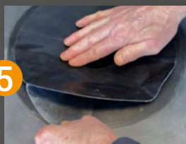
Einsetzen des Gullys
