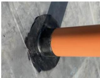
Waagerechte Durchdringungen (Zu-/Abwasser, Kabel) werden mit Formband im Kaltnahtverfahren angeschlossen.
